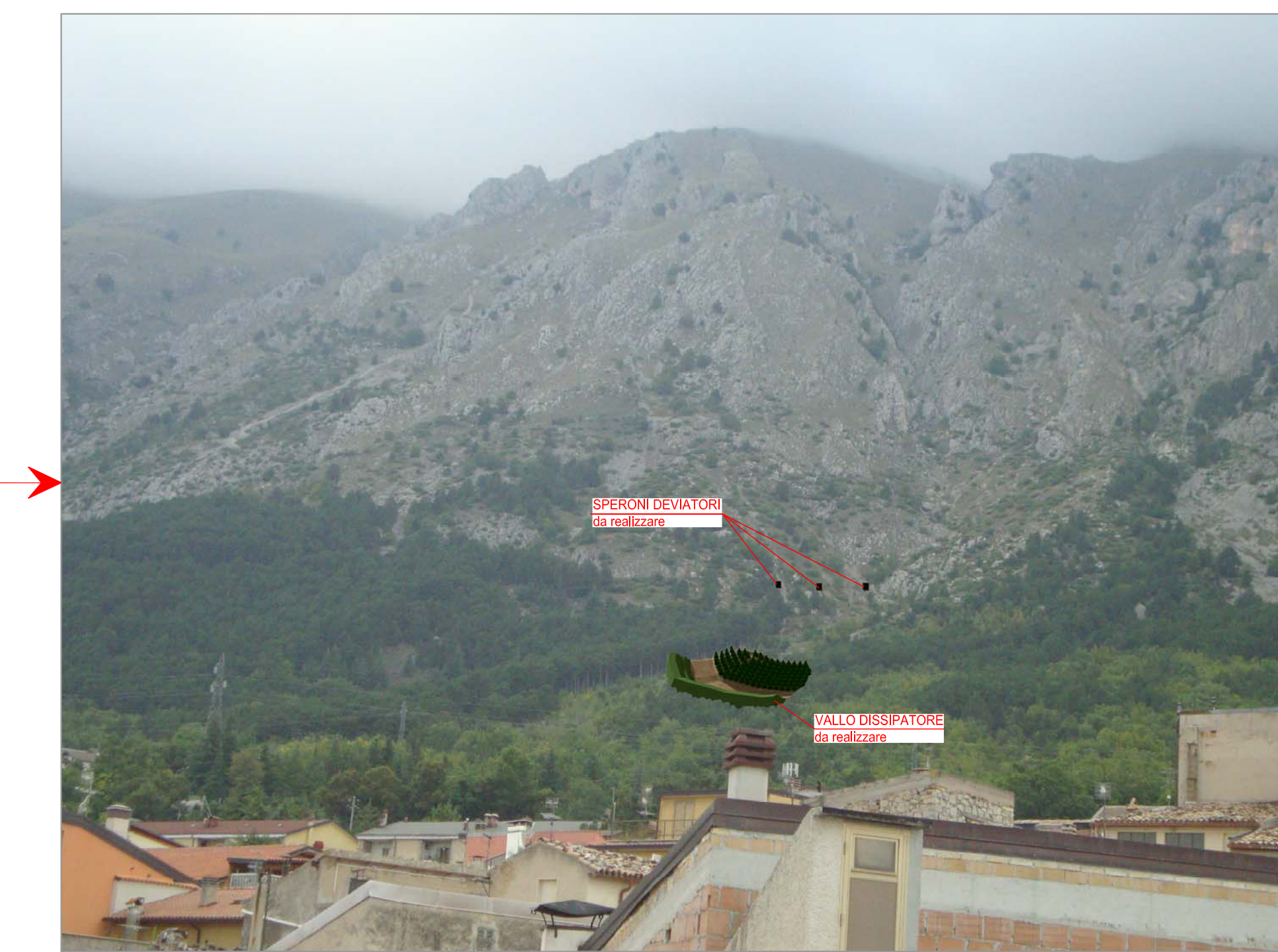
6 - VISTA DAL CENTRO ABITATO DI LAMA DEI PELIGNI - POST OPERAM
