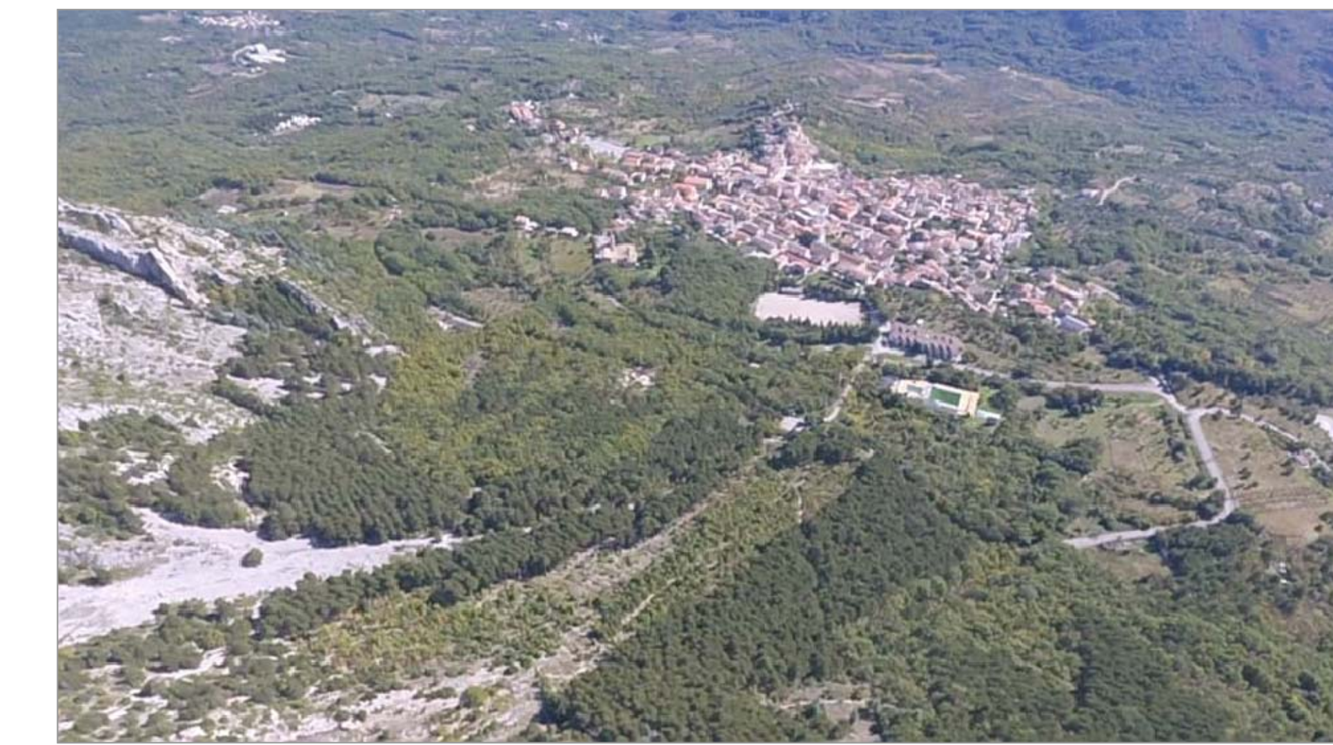
5 - VISTA DALL'ALTO LATO OVEST - ANTE OPERAM
